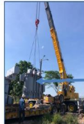
Descargue de transformador de 10 MVA Nº SERIE: 142859-1309 en la subestación Apiay
